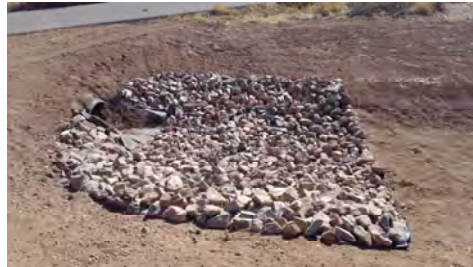
Loose rock riprap
